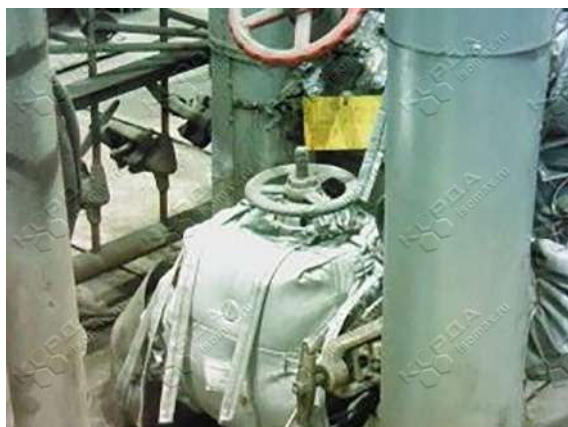
Рисунок Б 6 – Температура на поверхности термочехла на задвижке «Пар после фильтра №2» (ТГ-2)
