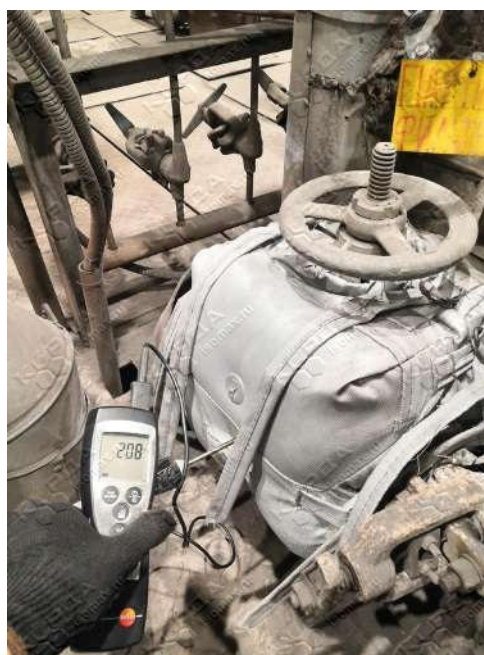
Рисунок А 6 – Замеры температура на задвижке «Пар после фильтра №2» (ТГ-2). Температура на поверхности термочехла – 44,4 (слева), температура на границе термочехол/арматура – 208°C (справа)
