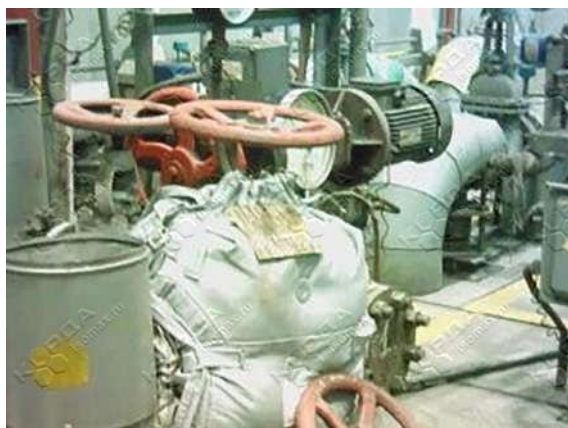
Рисунок Б 5 – Температура на поверхности термочехла на задвижке «Пар до фильтра №2» (ТГ-2)
