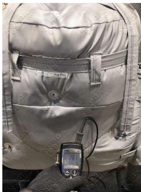
Рисунок А 2 – Замеры температура на задвижке «Пар после РПУ» (ТГ-2). Температура на поверхности термочехла – 41,7°C (слева), температура на границе термочехол/арматура - 287°C (справа)
