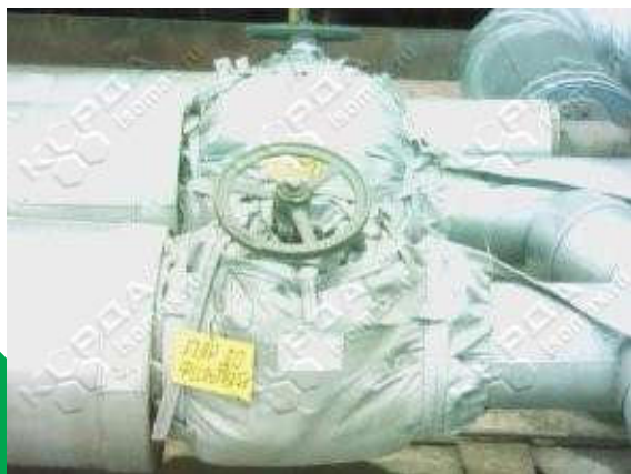
Рисунок Б 7 – Температура на поверхности термочехла на задвижке «Пар до фильтра №1» (ТГ-4)
