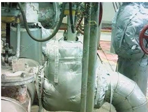
Рисунок Б 3 – Температура на поверхности термочехла на задвижке «Пар с РПУ на ПНД-1» (ТГ-2)
