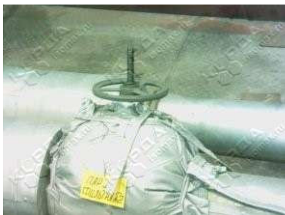
Рисунок Б 8 – Температура на поверхности термочехла на задвижке «Пар до фильтра №2» (ТГ-4)
