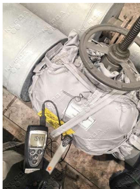
Рисунок А 8 – Замеры температура на задвижке «Пар до фильтра №2» (ТГ-4). Температура на поверхности термочехла – 29,4°C (слева), температура на границе термочехол/арматура – 154,1°C (справа)
