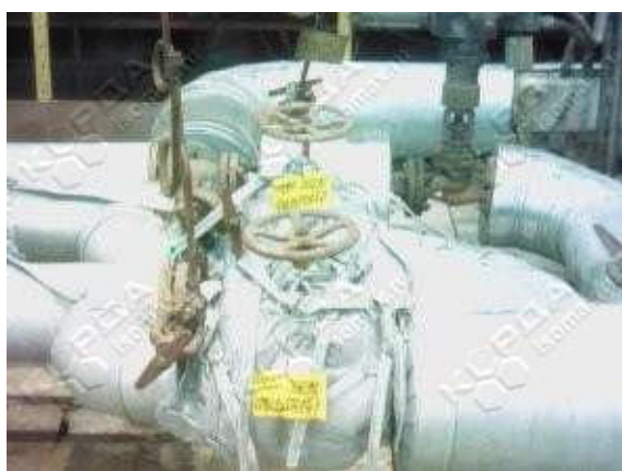
Рисунок Б 9 – Температура на поверхности термочехла на задвижке «Пар после фильтр №1» (ТГ-4)
