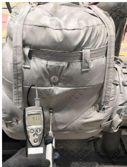
Рисунок А 2 – Замеры температура на задвижке «Пар после РПУ» (ТГ-2). Температура на поверхности термочехла – 41,7°C (слева), температура на границе термочехол/арматура - 287°C (справа)
