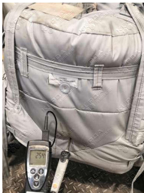
Рисунок А 1 – Замеры температура на задвижке «Пар до РПУ» (ТГ-2). Температура на поверхности термочехла – 39,6°C (слева), температура на границе термочехол/арматура – 254 °C (справа)
