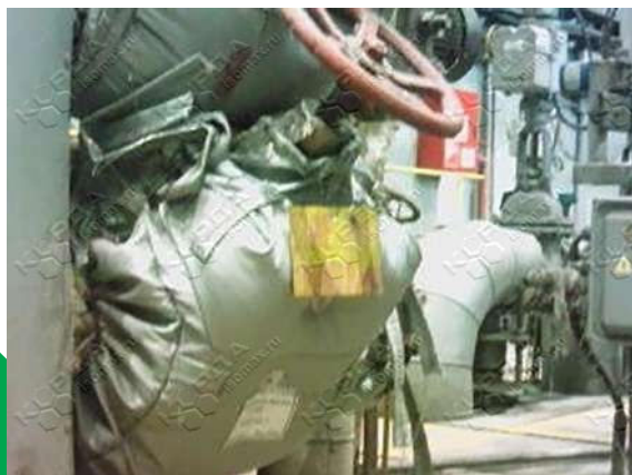
Рисунок Б 4 – Температура на поверхности термочехла на задвижке «Пар до фильтра №1» (ТГ-2)
