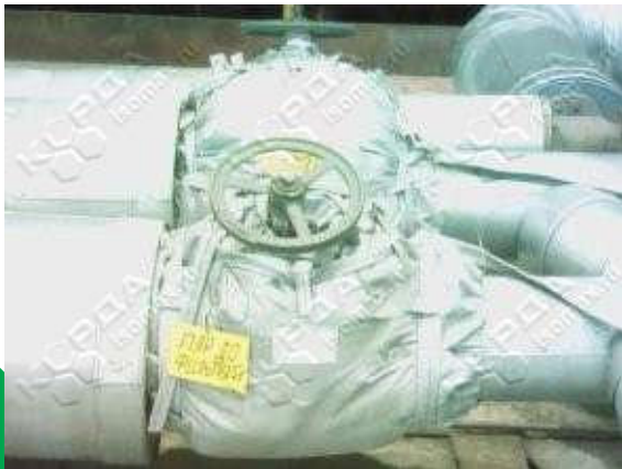
Рисунок Б 10 – Температура на поверхности термочехла на задвижке «Пар после фильтра №2» (ТГ-4)
