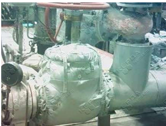
Рисунок Б 2 – Температура на поверхности термочехла на задвижке «Пар после РПУ» (ТГ-2)
