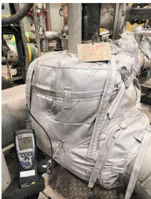
Рисунок А 3 – Замеры температура на задвижке «Пар с РПУ в ПНД-1» (ТГ-2). Температура на поверхности термочехла – 42,9°С (слева), температура на границе термочехол/арматура - 273°С (справа)
