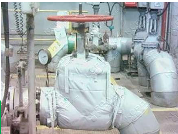
Рисунок Б 1 – Температура на поверхности термочехла на задвижке «Пар до РПУ» (ТГ-2)
